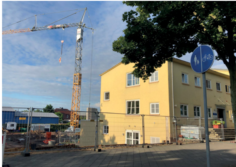
Baustelle an der Klinik (Foto: privat)
