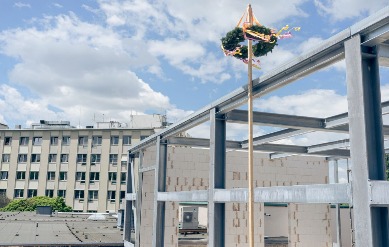
Der Richtkranz wurde Ende Mai am Erweiterungsbau der Universitätsklinik für Strahlentherapie angebracht.
