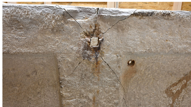
Detail der Sarkophagwand nach Entnahme der Eisenklammer, deren Korrosion die deutlich erkennbaren Risse im Kalkstein verursachte.
